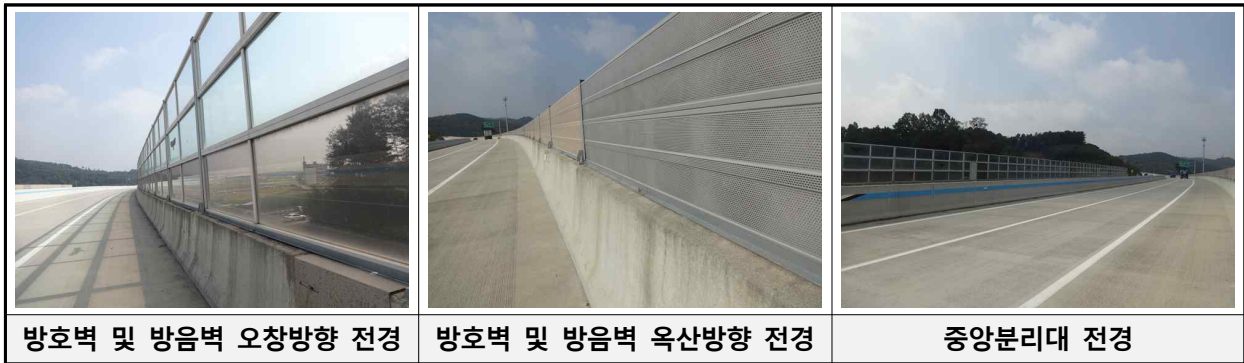
[방호벽 및 방음벽 전경]
