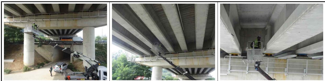
[고소작업차를 이용한 근접조사 실시]
