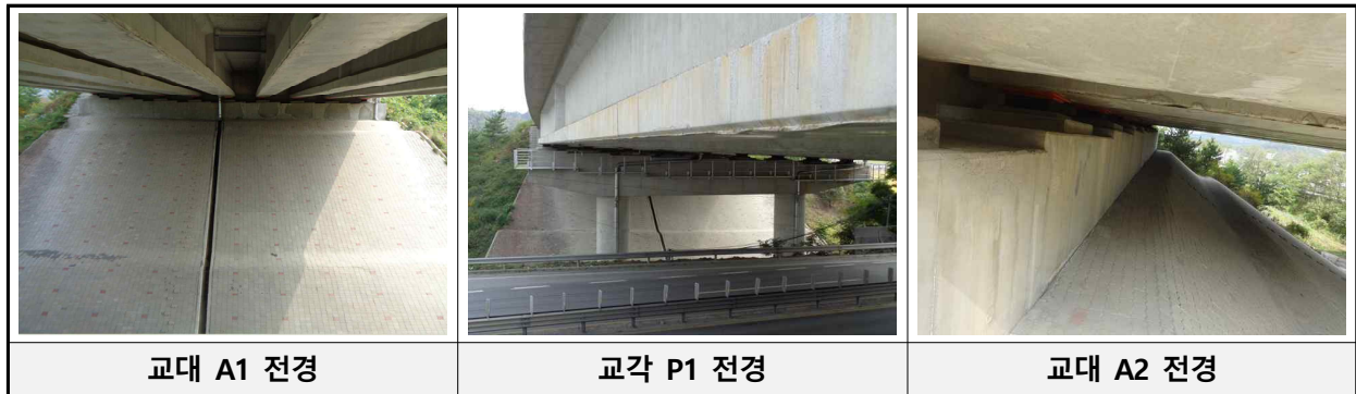
[교대 및 교각 전경]
